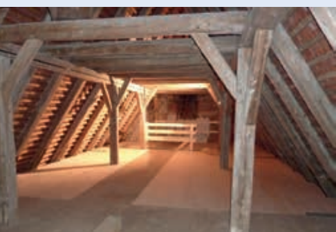
■ Ein eingebauter Zwischenboden im Dachstuhl. Foto: Ute Herr
